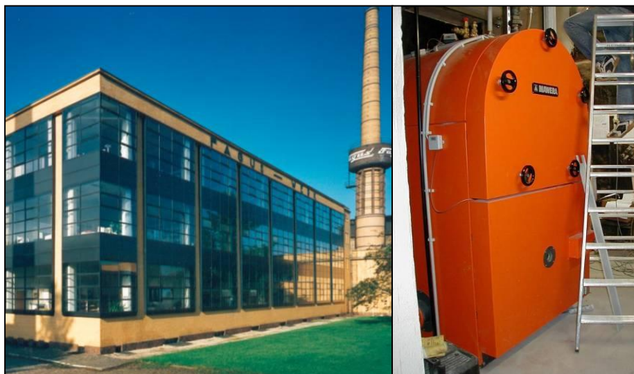
Ábra 26: Közintézményt ellátó 270 kW-os teljesen automatizált pelletkazán
