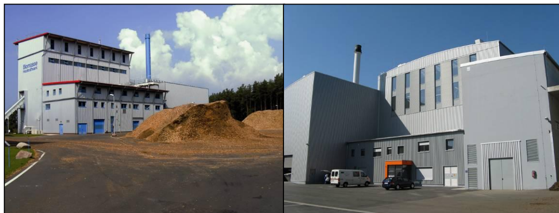
Ábra 35: 7,5 MW villamos teljesítményű elvételes kondenzációs turbinával (bal oldal) és 2,6 MW villamos teljesítményű fűtőturbinával (jobb oldal) szerelt víz-gőz ciklusú biomassza erőmű
